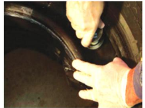
15. 接続部を合わせ、ボルトを手で緩く止める。
