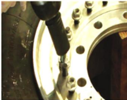
41. この状態でクランプボルトを外し、残りの22個のナットを締める。
